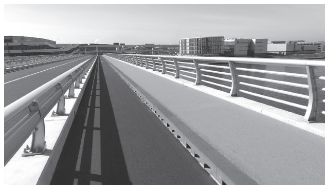
写真1 鋼製排水溝全景
