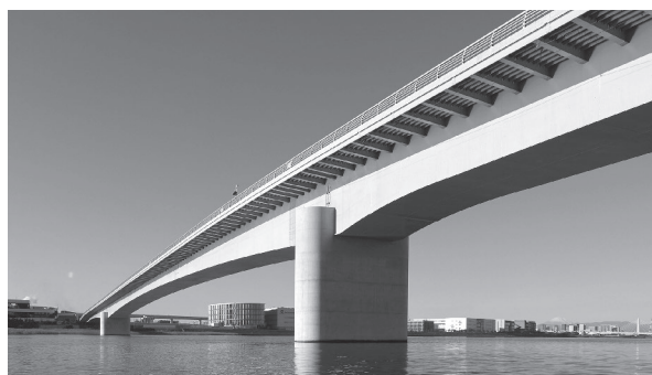
写真5 多摩川スカイブリッジ側面全景
