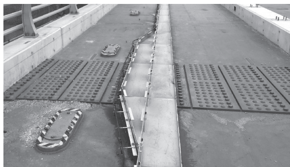
写真4 添接板付近の断面変化
