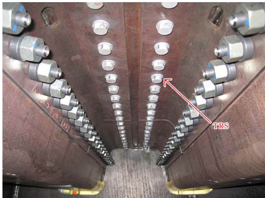
鋼床版のUリブ当て板補修
